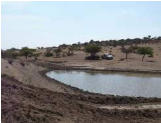
Construcción y Desazolve de Bordos Para Abrevadero
