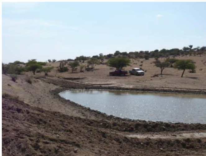
Construcción y Desazolve de Bordos Para Abrevadero
