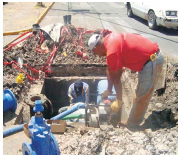
Fueron sustituidas 13 tomas domiciliarias que representaron deterioro en la calle Lázaro Cárdenas de la zona centro, los trabajos efectuados abarcaron desde excavaciones hasta reposición de concreto.
